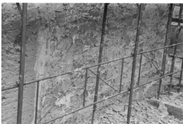
Otlčenie a osekávanie vrstiev omietky a vysekanie spoj. malty položky č. 28, 29, 30.
