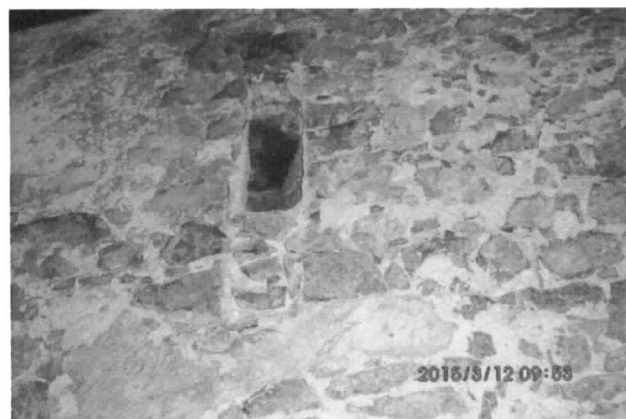
Jednovrstvové škárovanie z lomového kameňa položky č. 26 a 30.
